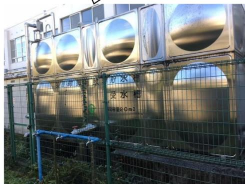
貯水槽は2年2組の教室の裏側あたりに配置されています。災害時に飲料水として使用されます(手前に非常用の蛇口あり)。中の水は循環させるために、普段は児童の水道水として使用されているそうです。
