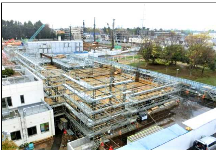
令和3年3月完成予定の新体育館工事の様子(4/5 撮影)
