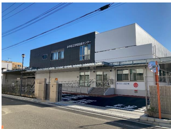
〈学校給食センター外観〉
