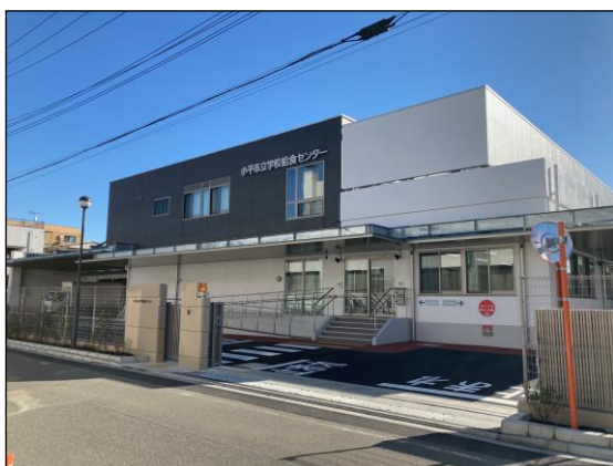
(学校給食センター外観)
